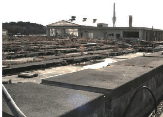
写真1 岩手県栽培漁業協会の被災状況
