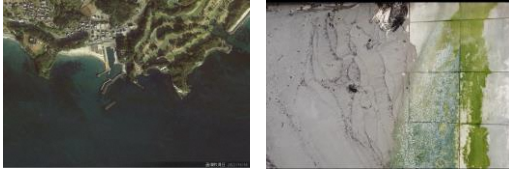
小浜漁港（泥が堆積した斜路）
