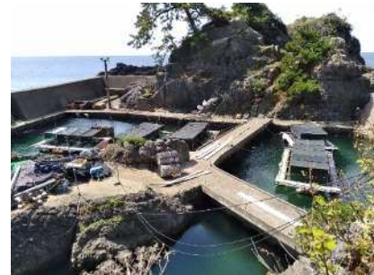
図1 米ノ中間育成施設の概観
