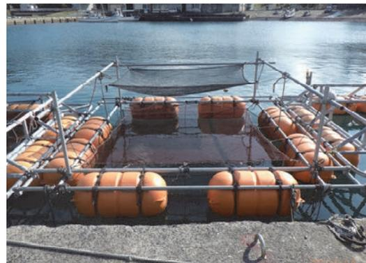
写真6 実際に作成した鋼管イケス
