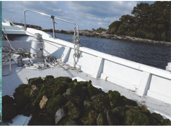
写真10 生産した藻場ブロック等の運搬
