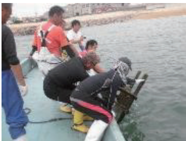
写真5 作業風景③
