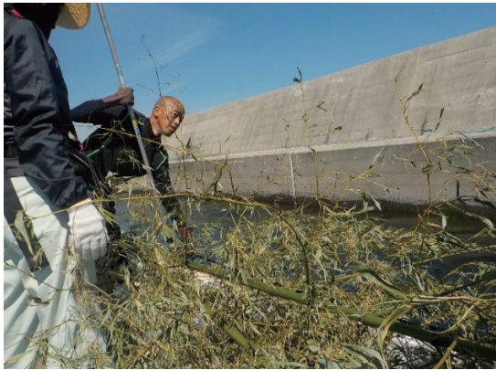
写真1 マダケ設置作業
