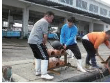
写真3 作業風景①
