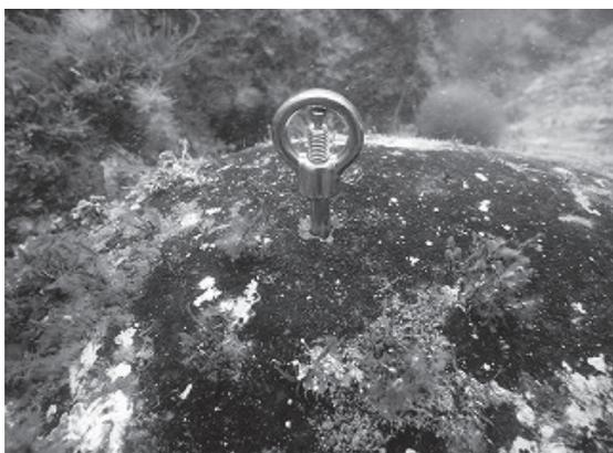
写真-3 アンカー打設
