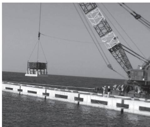
図 1 越湖海岸に沈設された人工魚礁
