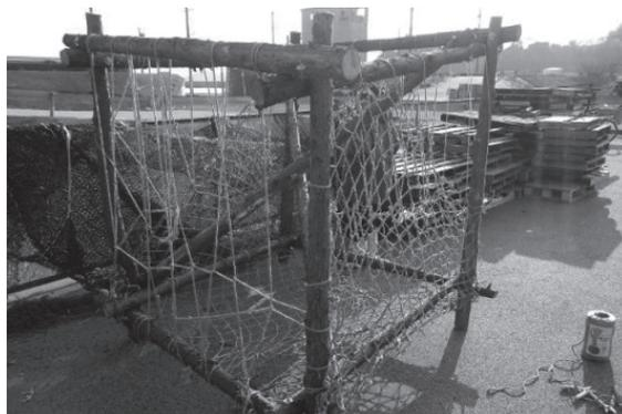
写真 3 間伐材魚礁の枠の完成
