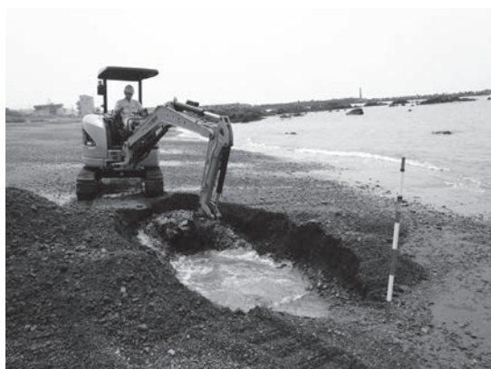
写真5 鉄鋼スラグ袋の埋設
