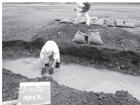
写真6 埋設作業の様子
