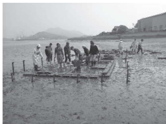
写真4 ブロックの設置
