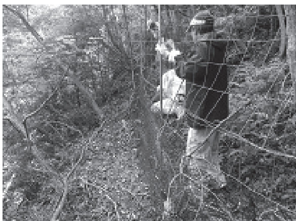
防護柵の補修
