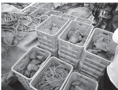
写真 4 割栗石を詰めたコンテナ
