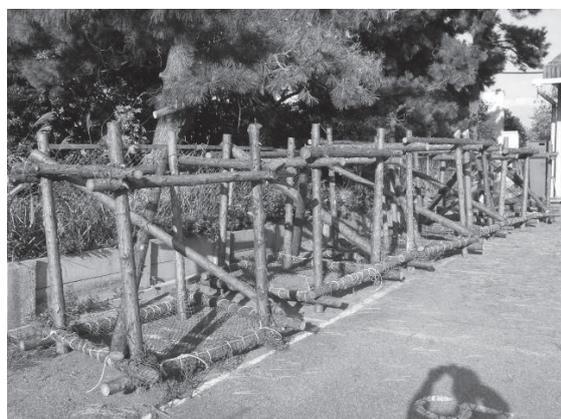
写真 3 間伐材魚礁の枠の完成
