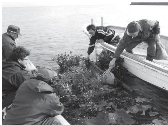
写真 5 間伐材魚礁の沈設
