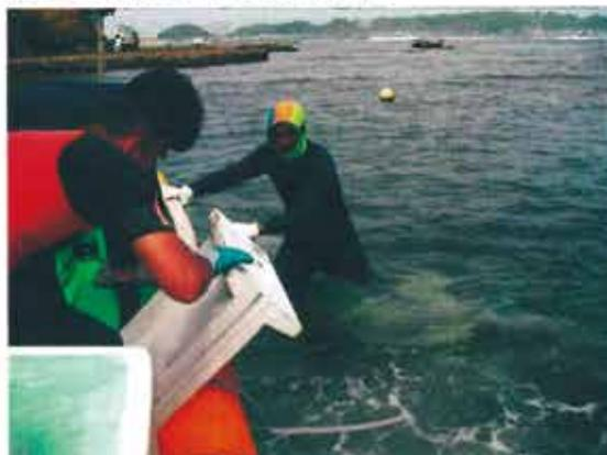
写真2 コンクリート平板の投入作業
