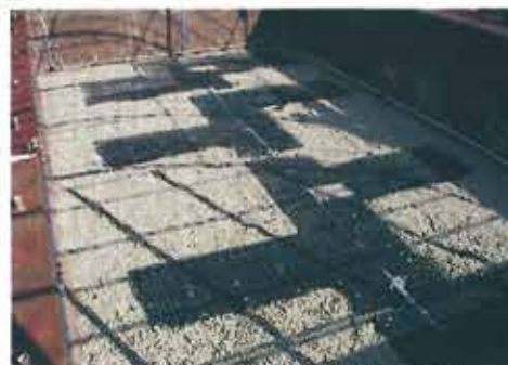
写真2 砂を敷設した馴致水槽
