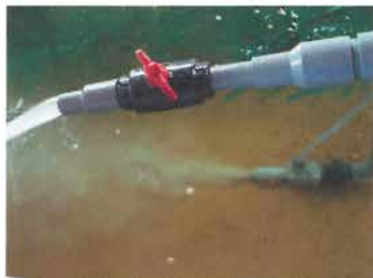
写真1 海水注水(上)とエアー混合注水(下)
