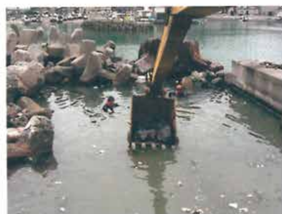
写真5 重機と漁業者による海底の整地
