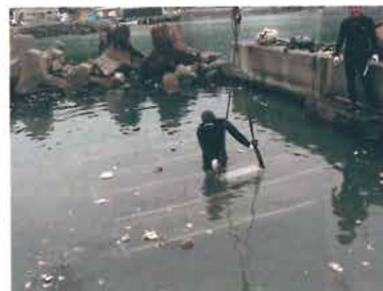
写真6 コンクリート製側溝の設置
