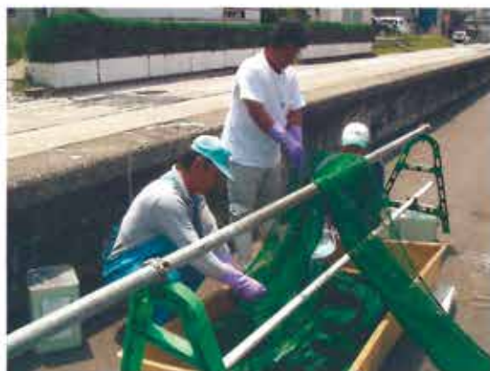
写真1 囲い網へのシリコン塗布作業
