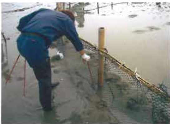
写真3 さらに鉄杭で補強する
